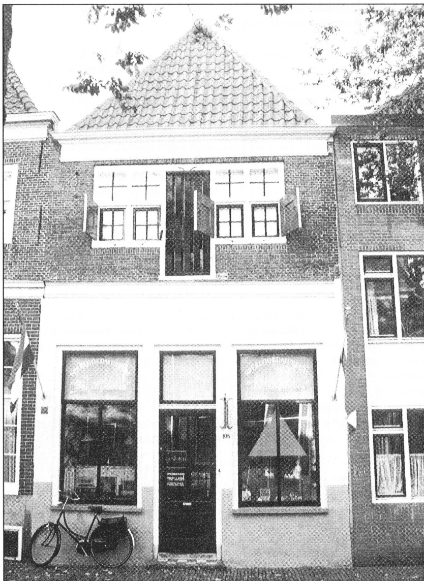
Voorgevel Italiaanse Zeedijk 106. In het pand is sinds 1995 Speelgoedmuseum De Kijkdoos gevestigd (foto 2000).
