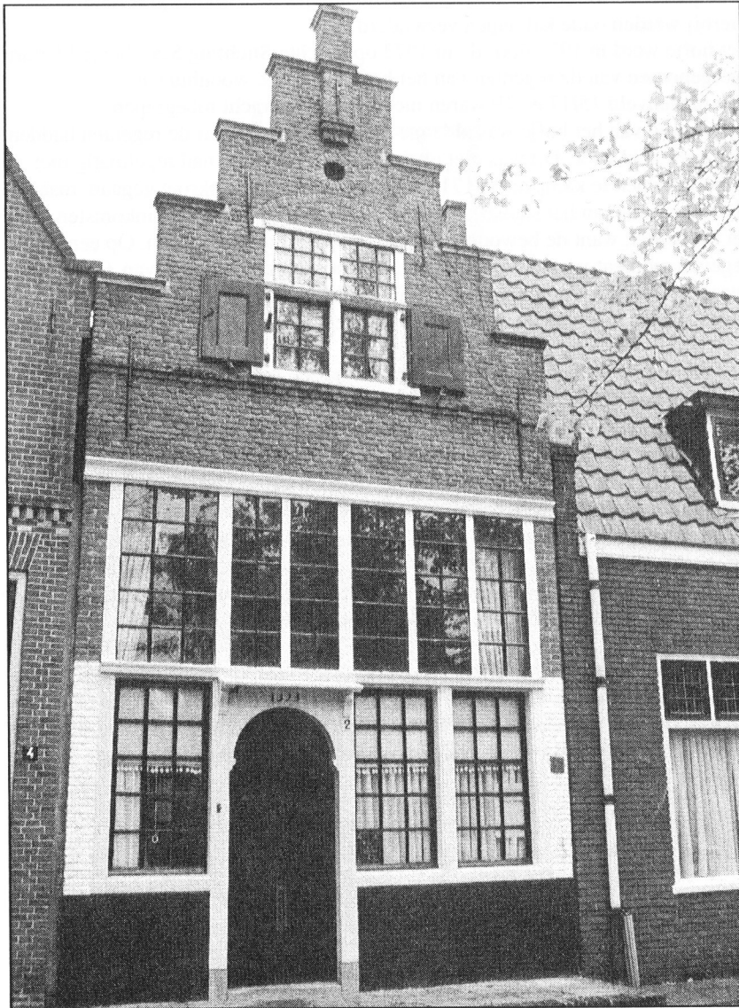
Munnickenveld 2 met trapgevel, 2000.
